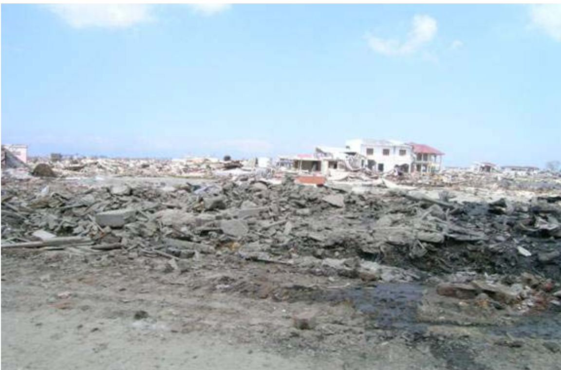
(アチェ市海岸付近。鉄筋やレンガ作りの繁華街や高級住宅街も根こそぎ流された。)
